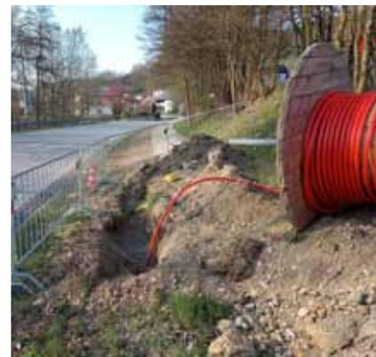
In weiten Teilen nutzt auch die LinzStrom die Gelegenheit, um Stromleitungen unter die Erde zu verlegen. Für die Anrainer bedeutet dies, dass sie mit einer einzigen Aufgrabung sowohl die Glasfaser- als auch die Stromleitungen bekommen können.
